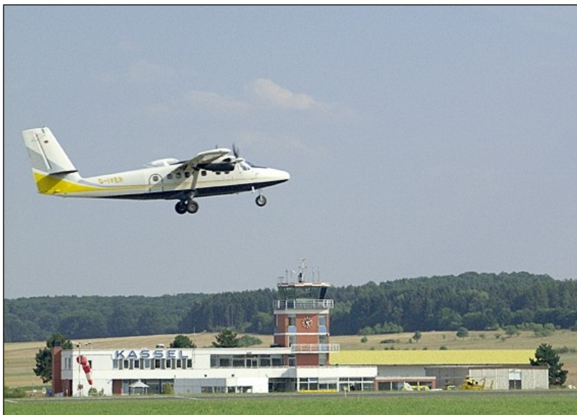
Der alte Verkehrslandeplatz
